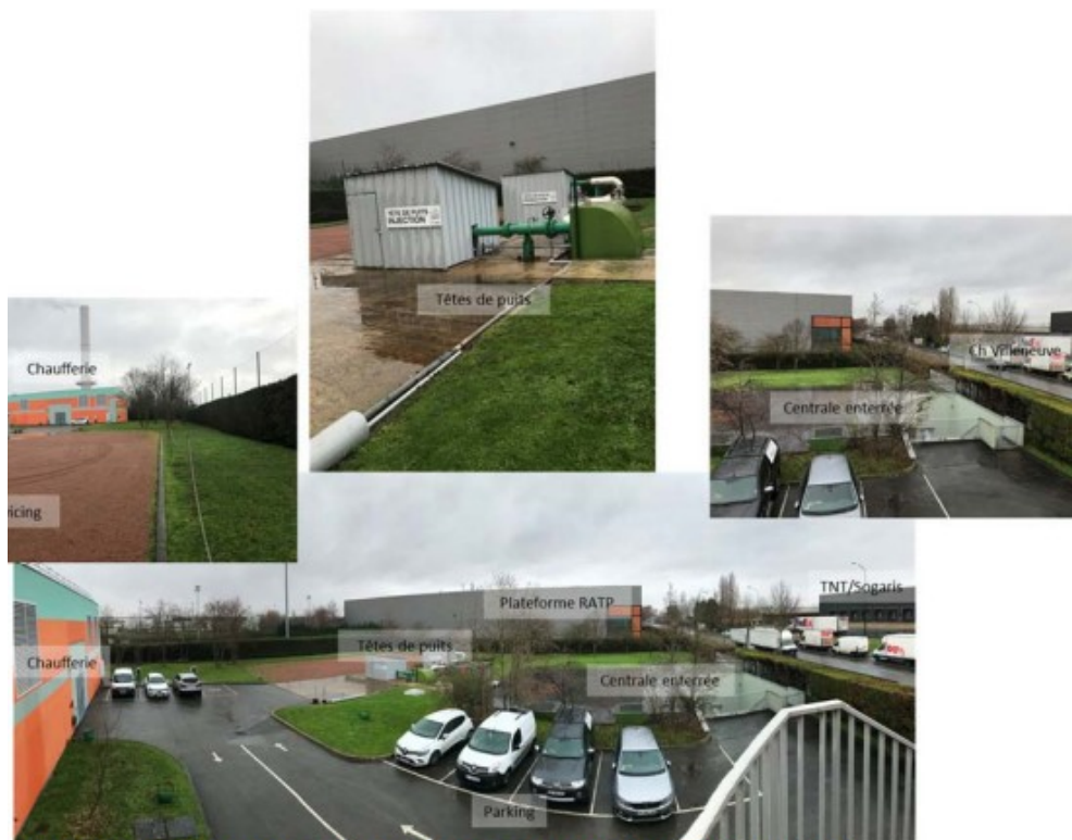
Figure 1 : Situation actuelle du site d'implantation du chantier côté SMAG (source CFG)
